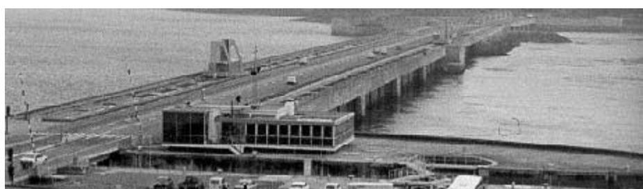
Figuur 5 Getijcentrale bij La Rance in Frankrijk. De eerste (1966) en voorlopig enige centrale in Europa met een vermogen van 240 MW. De huidige kostprijs voor de elektriciteit bedraagt omstreeks f0.06 per kWh.
