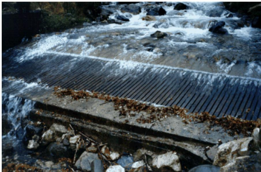
Questo tipo di presa è in grado di rimuovere il 50% dei solidi fino a 0,5 mm, il che consente di non prevedere il bacino dissabbiatore con i relativi sistemi di rimozione del sedimento. La presa è brevettata da AQUA SHEAR e distribuita in Europa da DULAS<sup>11</sup>.
