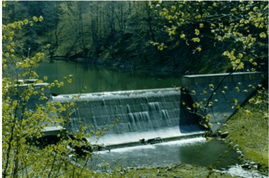
velocità dell'acqua scaricata, solitamente alla base degli scarichi è realizzato un sistema di dissipazione dell'energia.
