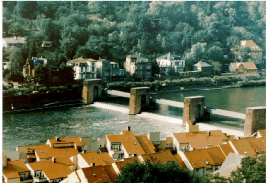
della chiusa, è interamente interrata e non si vede dalla riva. La figura 7.13 mostra meglio di quanto non possano fare le parole, il progetto, che ha previsto l'installazione di due turbine Kaplan ad asse orizzontale di potenza 1.535 kW ciascuna. Il costo d'investimento è stato naturalmente molto alto, circa 3.760 ECU per kW installato.
