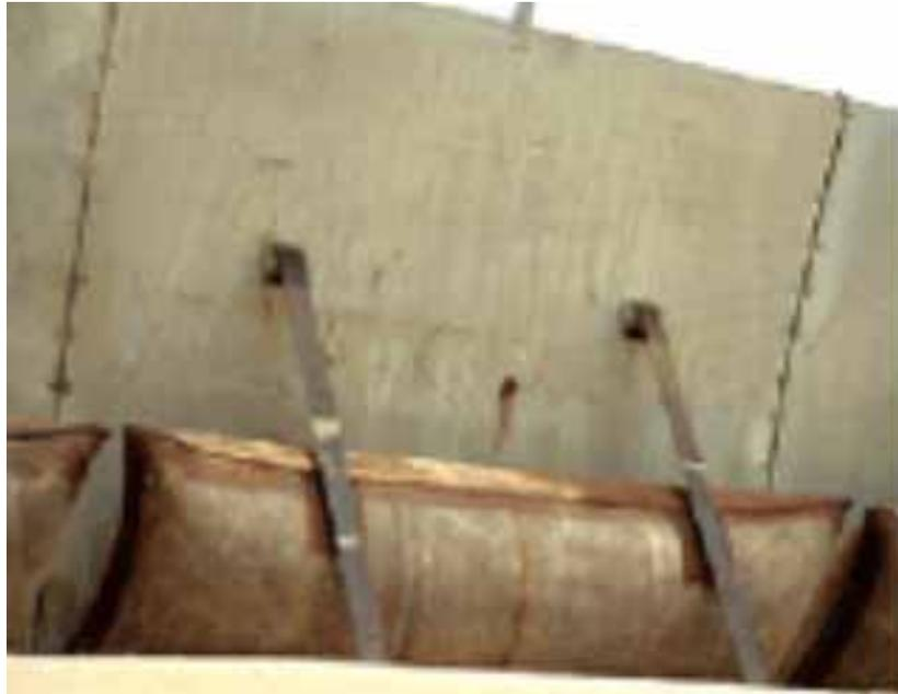
Attualmente un sensore elettronico controlla il livello d'acqua a monte e la pressione interna della camera del gommone. Un microprocessore mantiene costante il livello alla presa tramite piccoli cambiamenti sulla pressione interna della camera. Per evitare esondazioni a monte, un dispositivo analogo può controllare il gommone in modo da mantenere un livello a monte preimpostato.
