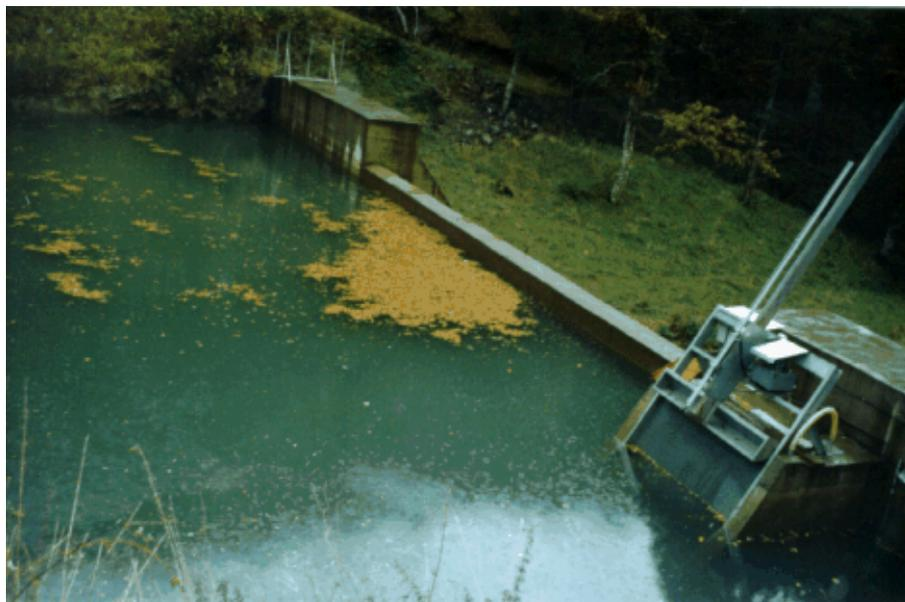
L'orientamento della presa rispetto alla corrente è un fattore cruciale per impedire l'accumulo di materiale sulla griglia, fonte di problemi di manutenzione e causa di fermi impianto.
