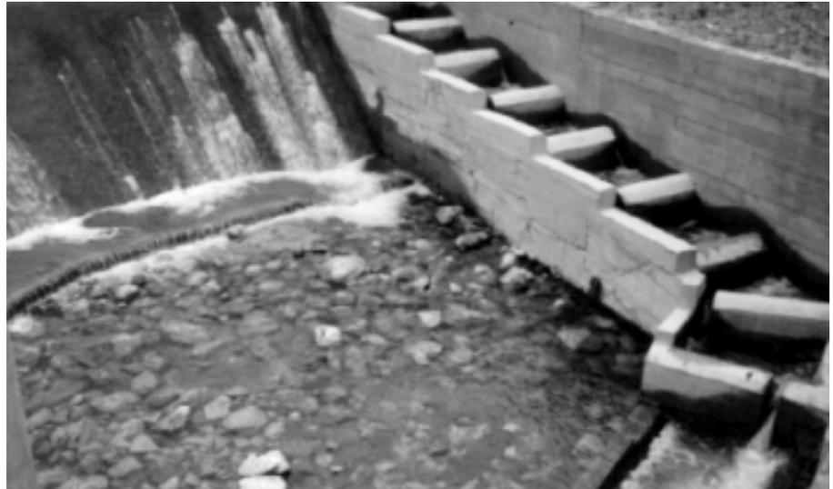
La fotografia 7.15 relativa ad un piccolo corso d'acqua nelle Asturie (Spagna) mostra una scala con fessure verticali e luci di fondo che solitamente fornisce buoni risultati. La forma e la disposizione dei setti sono mostrati schematicamente ed in prospettiva nella figura 7.4.; la larghezza dei bacini, per lunghezze comprese tra 1,8 e 3,0 m varia tra 1,2 e 2,4 m. Il dislivello tra i bacini è dell'ordine di 25-40 cm. Le alose richiedono dislivelli non superiori a 25 cm.
